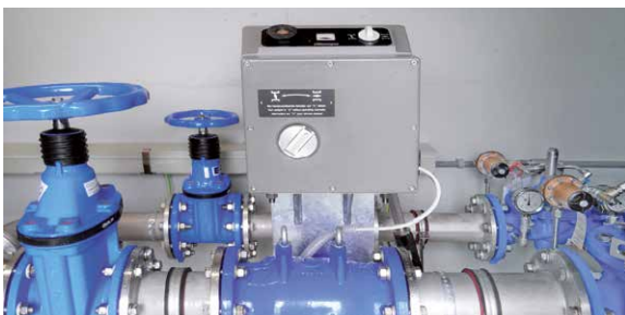
Regulierventil bei grossen Fallhöhen
