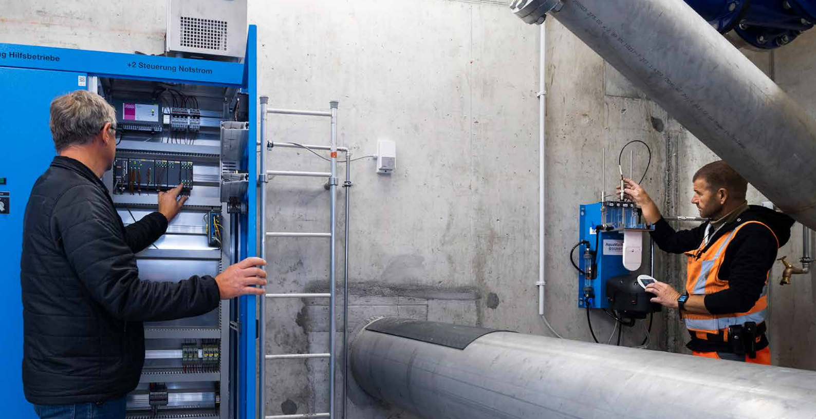
Die kompakten Messstationen wurden an strategisch wichtigen Punkten installiert. Qualitätsparameter kann man so konkret der einzelnen Quelle zuordnen.
